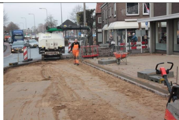
Machine is inzetbaar op klein werk. Goed te zien, een gootlaag of stellaag behoort tot het 'reststraatwerk'.
