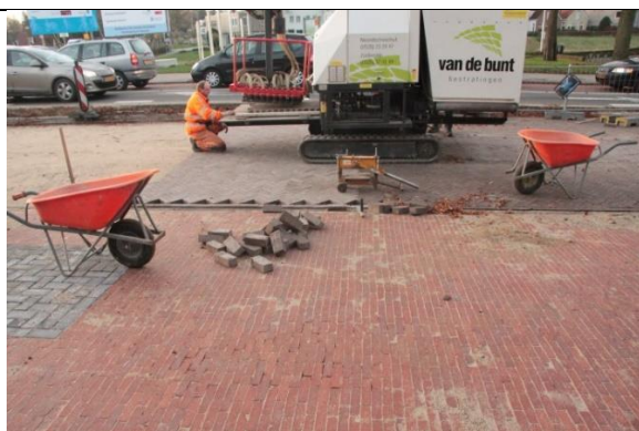
Waarneembaar, stenen komen op een plateau. Het voordeel hiervan is dat er met name bij herstraatwerkzaamheden passtukken kunnen worden toegevoegd aan het legpakket.
