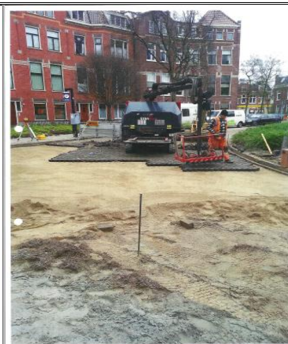
Middels een bijpassende klem worden de stenen aangebracht.
